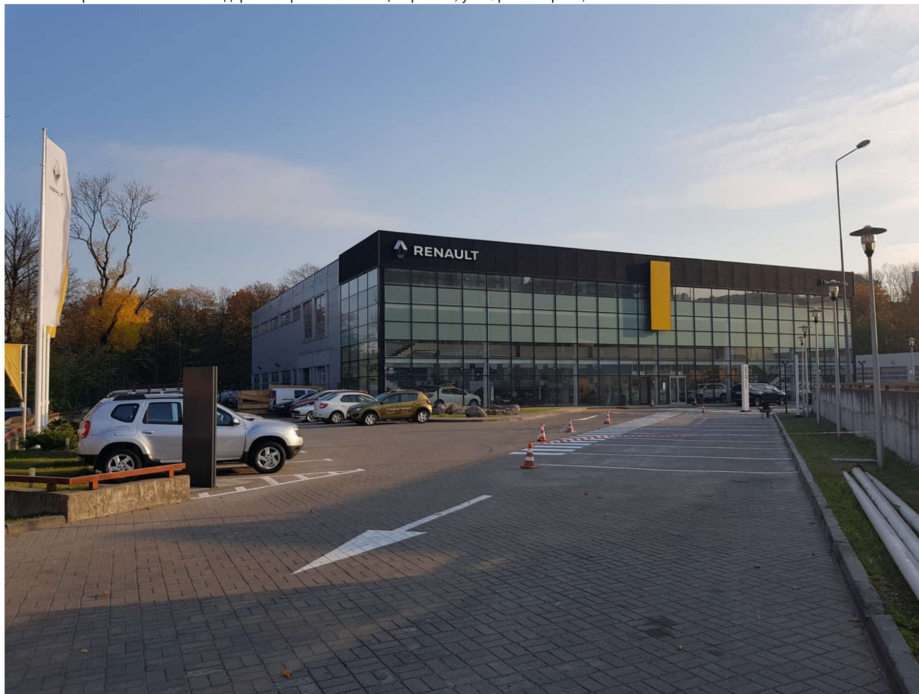
Выполнены работы по нанесению дорожной разметки Автоцентр Рено, ул. Юрия Гагарина, 2К
